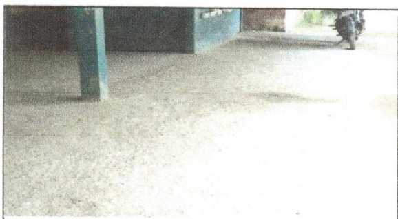
Foto 3: INSTALACION DE PISO CERAMICO EN LOS DIFERENTES MODULOS
