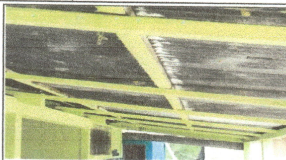
Foto 2: SUSTITUCION DE COSTANERA DE MADERA A METALES
